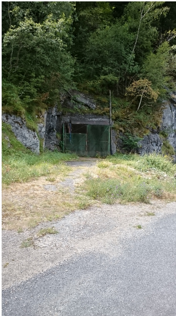
Entrée actuelle de l'ancienne mine
