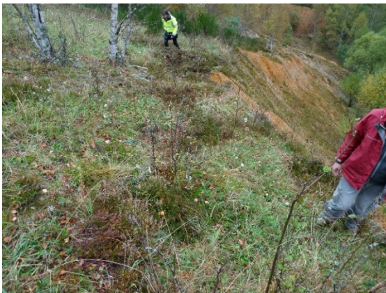
Rupture de pente en pied du talus supérieur Octobre 2013
