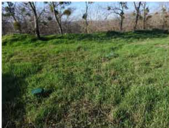
Zone de la fosse septique
