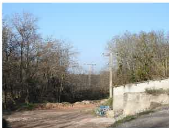
Vue sur la ligne électrique haute tension
