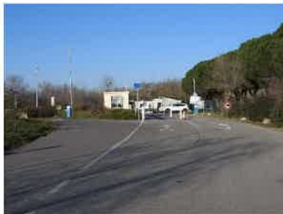
Vue sur le local d'accueil et de pesée de la déchèterie
