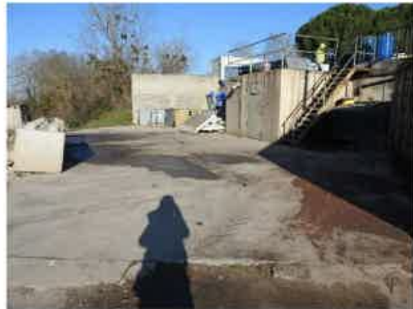
Aire de lavage et local
