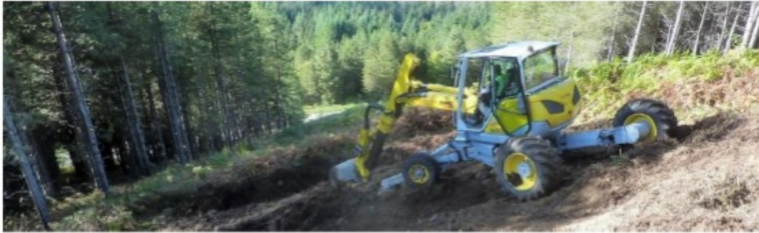
Exemple de pelle araignée utilisée dans le cadre des travaux liés au renouvellement du téléphérique de Luzenac – CBE, 2018
