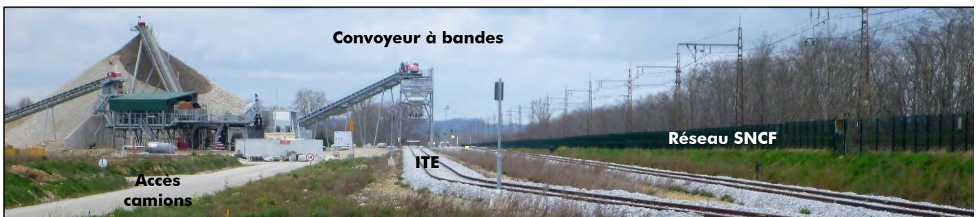
2 – Vue l'Installation Terminale Embranchée (ITE) de la Sablière Malet
