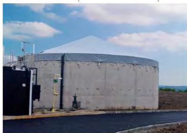
Exemple de cuve béton couverte par une bâche souple
