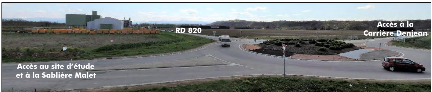
Giratoire sur la RD 820 permettant l'accès au site d'étude
