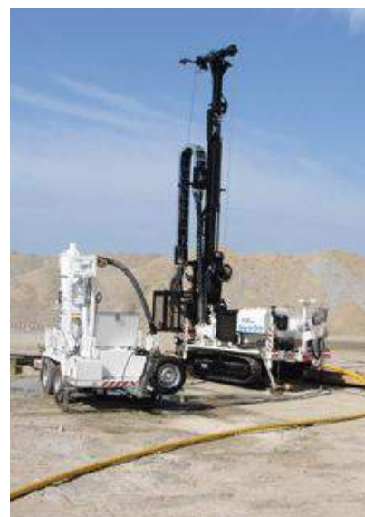
Figure 3 : Foreuse à circulation inverse
