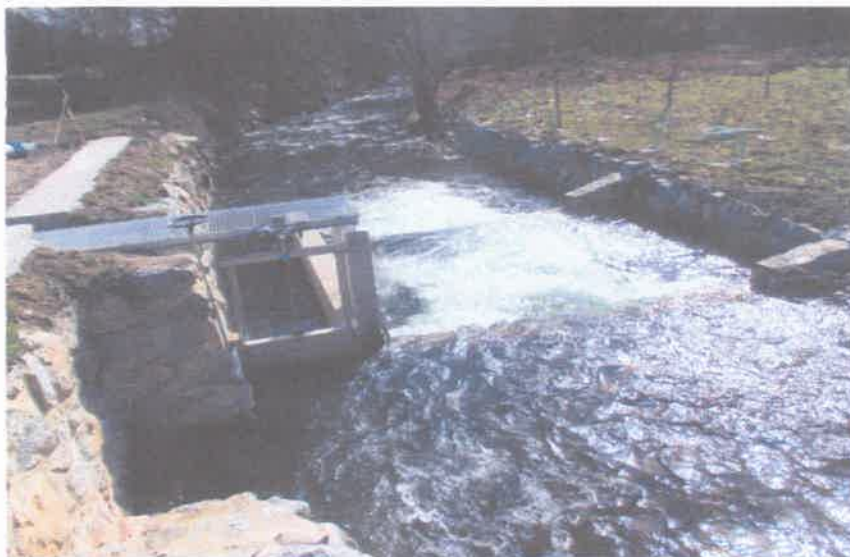
Le nouvel ouvrage et ses deux pré-barrages, vu de l'amont.
