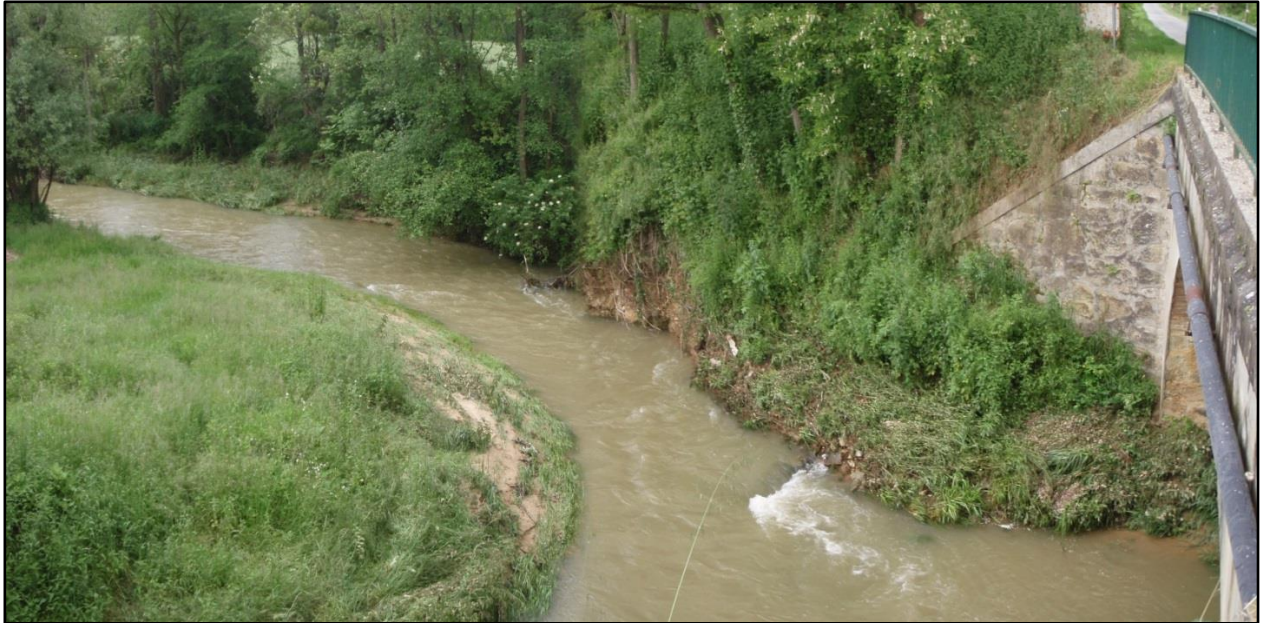
Figure 3 : La Lèze au pont de la D27b après la crue de juin 2013 (source : AGERIN sas)
