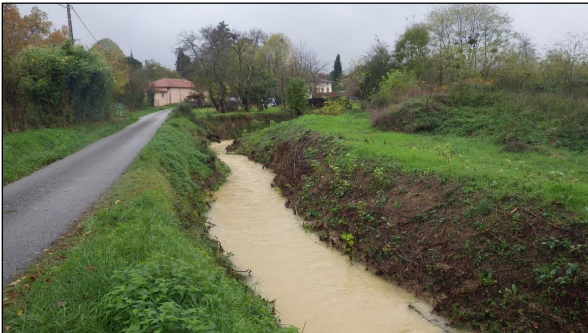
Figure 5 : Le Ruisseau d'Artigat à l'aval de la RD 919 pendant la crue du 20 novembre 2013 (source : AGERIN sas)
