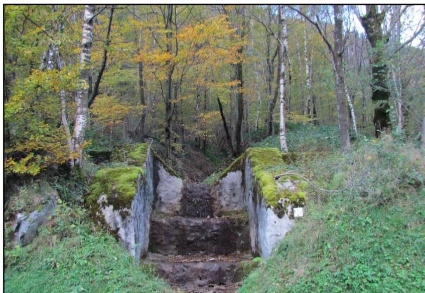
**Figure 16 : Correction torrentielle face au hameau de Mounicou (source : AGERIN<sub>SAS</sub>)**
