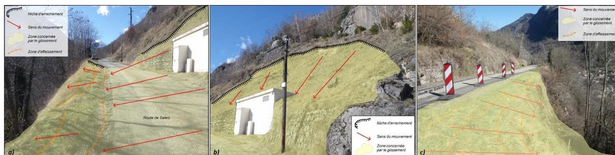
**Figure 39 : Niche d'arrachement et signes d'affaissement visibles le long de la route de Saleix (a et b). Balisage routier en place à cause d'un affaissement de la route (Source AGERINSAS)**
