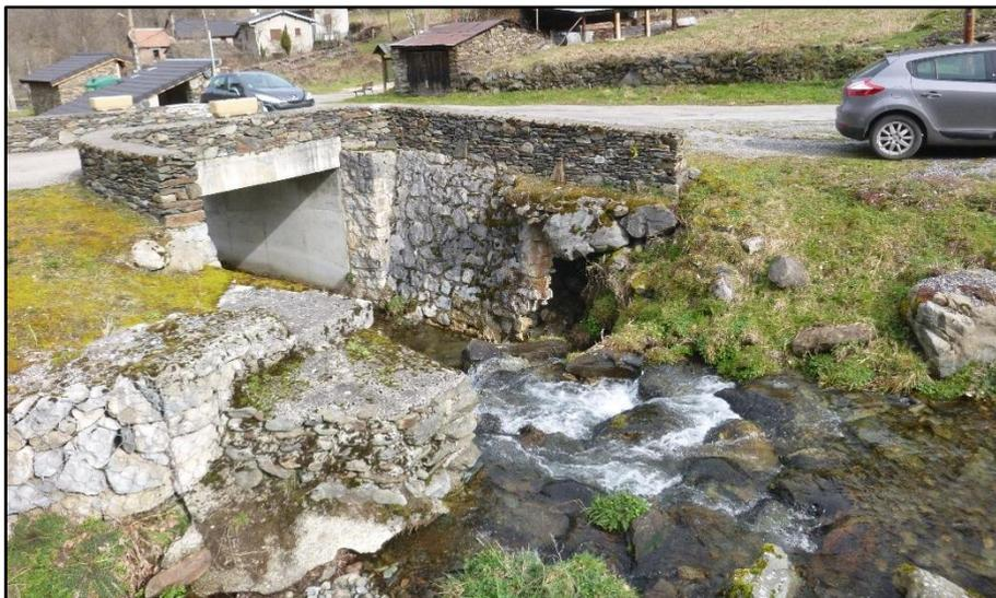
**Figure 8 : Parement déchaussé du mur de soutènement du pont d'Artiès (source : AGERINSAS)**
