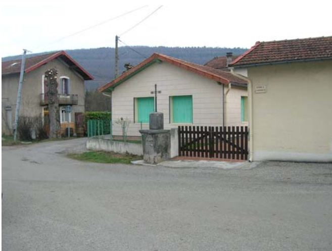
Photographie 9 : Maisons inondées en 1977 (Source : AGERIN)
