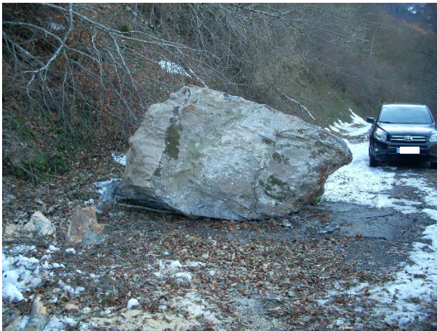
Chute de bloc route de la mine -2014
