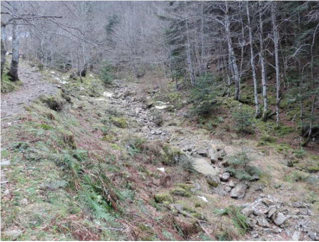
Mobilité du lit de l'Anglade en amont du barrage : divagation, reprise et dépôts de matériaux, érosions et affouillements...
