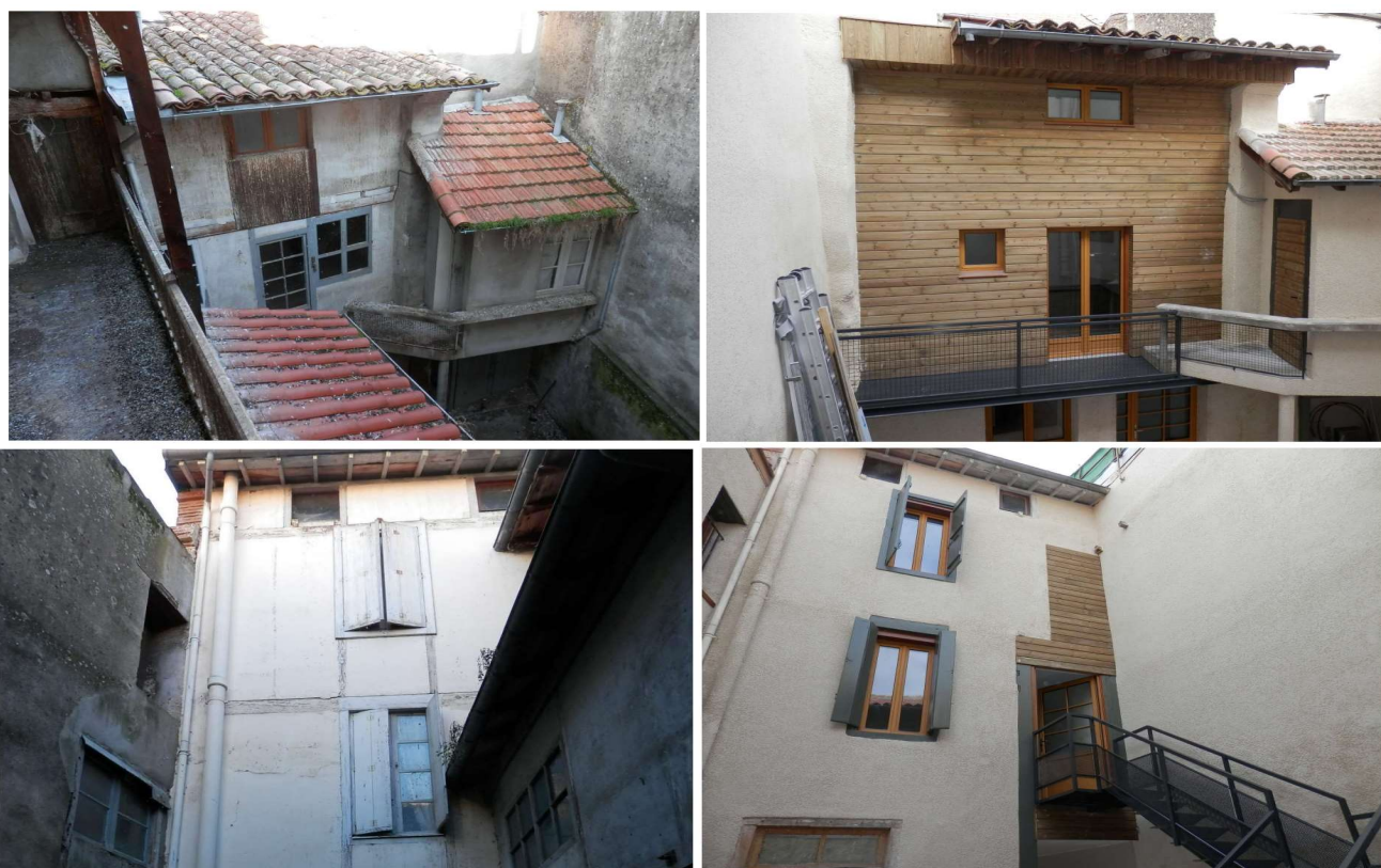
Propriétaire bailleur – Rénovation complète d'un immeuble en centre-ancien de Pamiers Travaux lourds, 4 logements dont 3 logements sociaux (1 T4 de 68 m 2 , 2 T3 de 60 m 2 ) Financement de l'opération à 50 % (Anah, Région, Département et Communauté de Communes)
