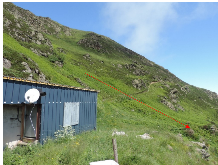
Tête du bassin d'alimentation de la branche sud
