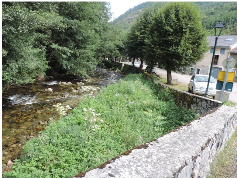
Enrochement de berge en soutènement de l'accotement de la Rd 224
