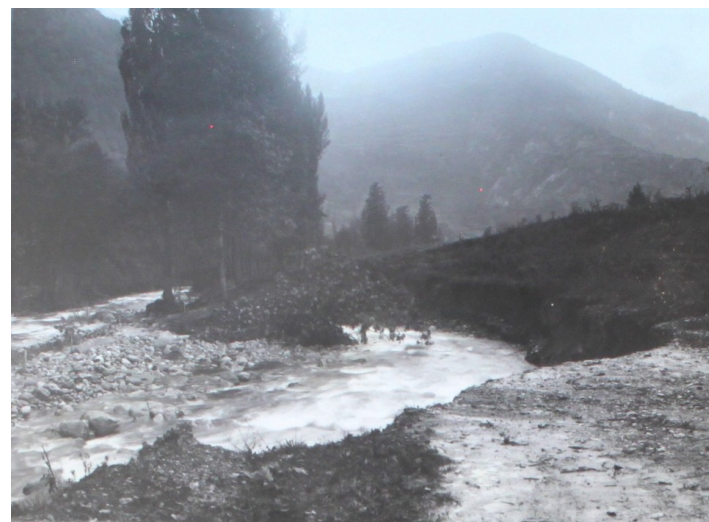
Source : Mairie 1937 – La route emportée
