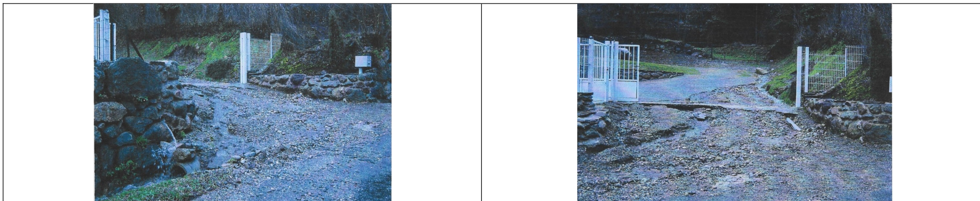
Crue du ruisseau de la Chapelle St Nicolas - janvier 2004 - Source : cliché particulier
