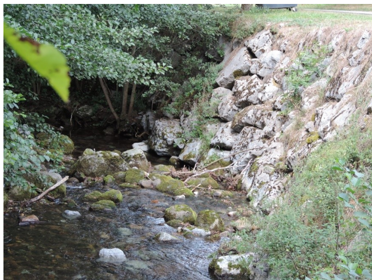
Enrochement de berge en soutènement de l'accotement de la Rd 224
