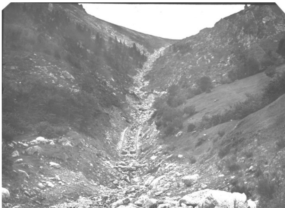
1891 : Exécution de murs de soutènement sur propriété de particuliers
