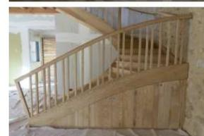
La structure (ossature et solivage) est en bois. Côté aménagement intérieur, le bar est en merisier et en frêne ; les portes, fenêtres et parquets en chêne et en châtaignier ; l'escalier en frêne.
