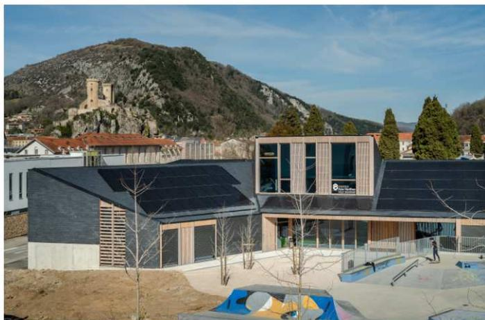
Charpente et ossature bois, cage d'ascenseur et plancher rez-de-chaussée en béton.
