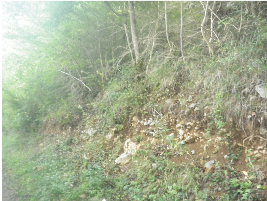
Figure 4 : Colluvions le long de la piste (Source AGERIN)
