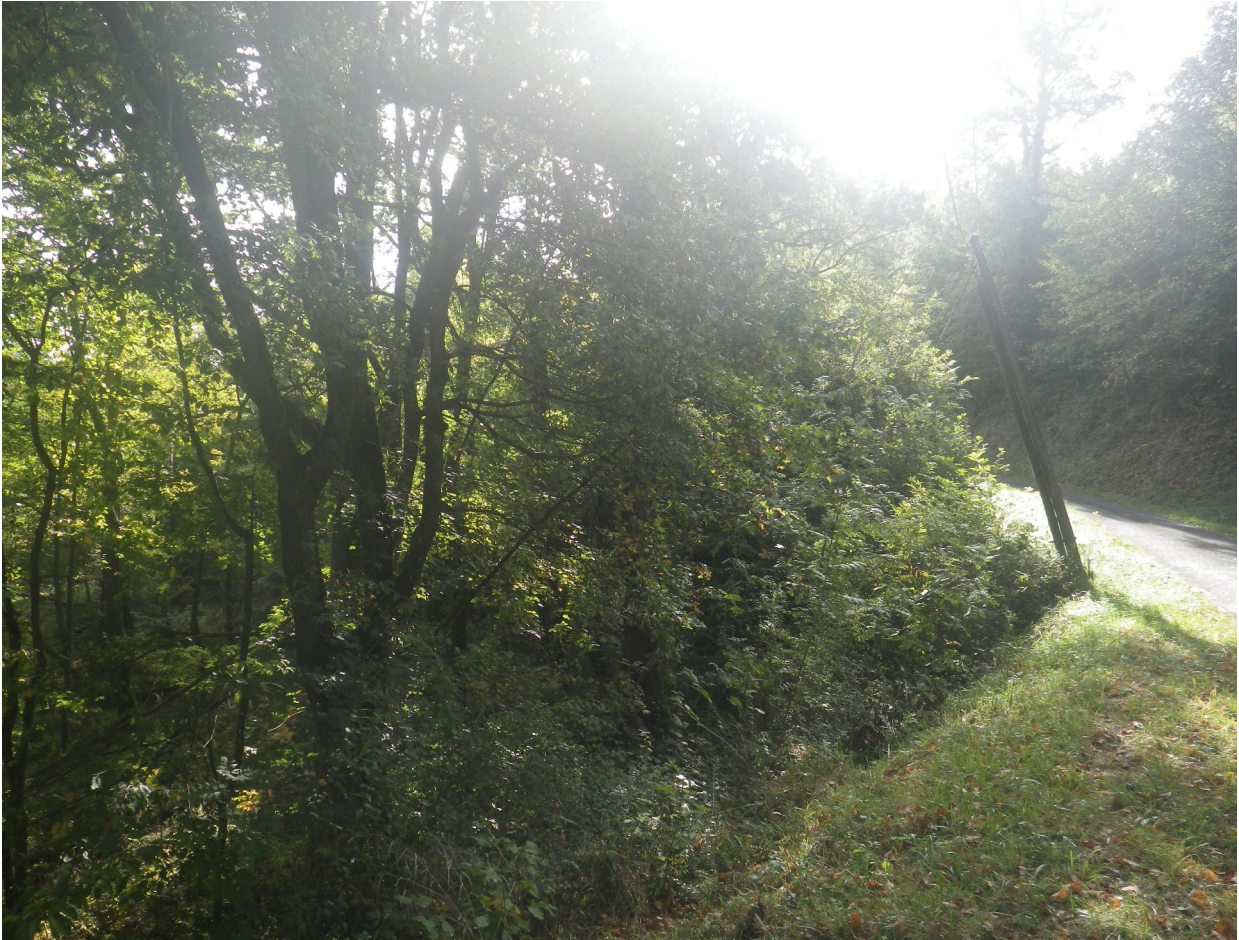
Figure 10 : Route à l'amont de Gelach : poteaux penchés, arbres en crosse et désordre sur chaussée (Source AGERIN)
