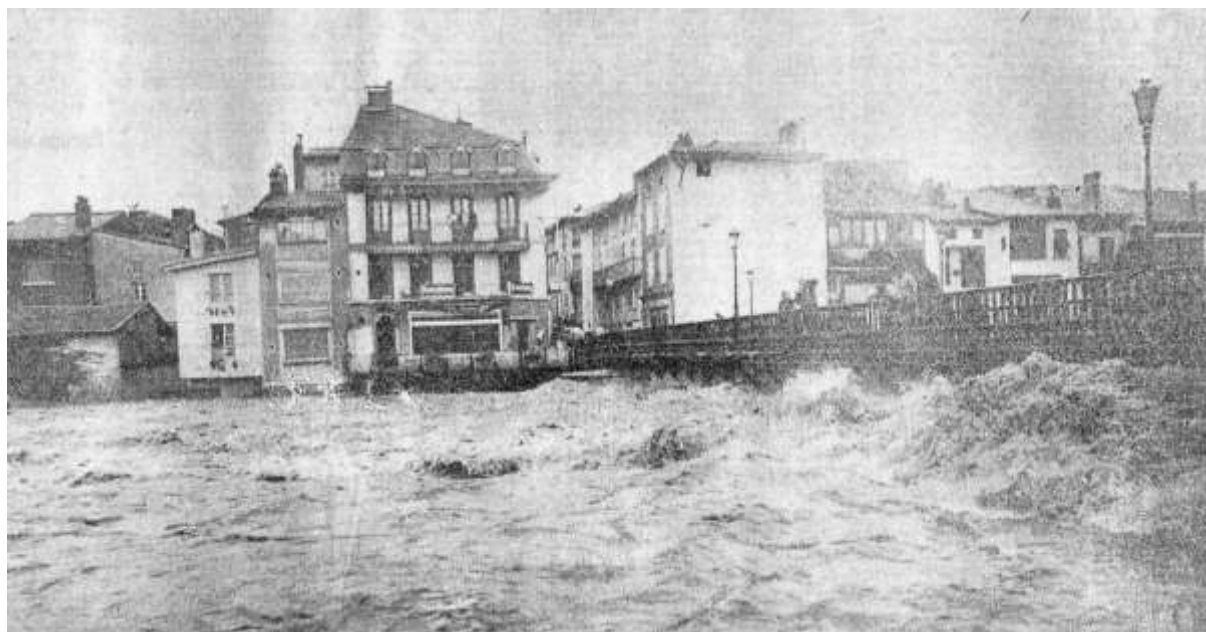
Photo 1 : Le pont de Saint-Girons lors de la crue de 1977 (Cliché « La Dépêche du Midi »)
