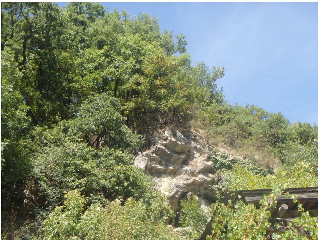
Figure 3 : Section fracturée d'un des affleurements rocheux à l'aplomb des bâtiments (AGERIN)
