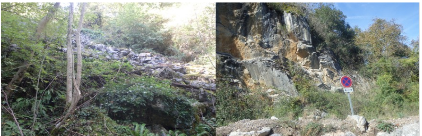
Figure 5 : Éboulis vifs et affleurements rocheux au niveau de la piste forestière (Source AGERIN)
