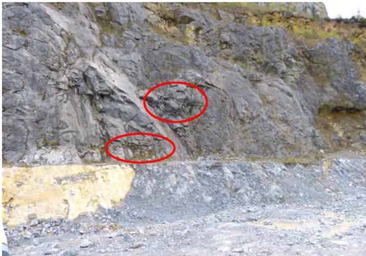
Sur les photographies ci-contre, entourées en rouge des arrivées d'eau. En fond de fouille, accumulation d'eau en point bas (18 avril 2012), suite à des précipitations récentes.
