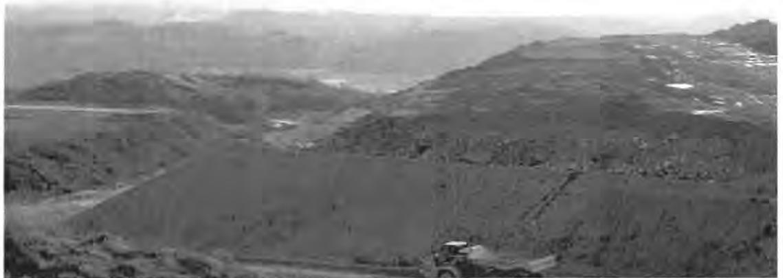
Les lignes de collines, formées de stériles, prennent forme petit à petit, sculptées par les engins de chantier des carrières en exploitation. PHOTO GUY DROLLET
